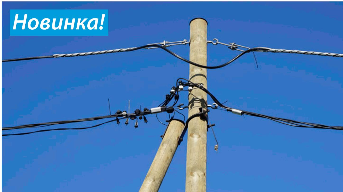
Универсальные кабели типа EXCEL/FXCEL и AXCES являются новым решением для сетей среднего класса напряжения. Эти кабели имеют самонесущую конструкцию и предназначены специально для прокладки по стандартным опорам ВЛ, но также могут быть прокладываться в земле.
