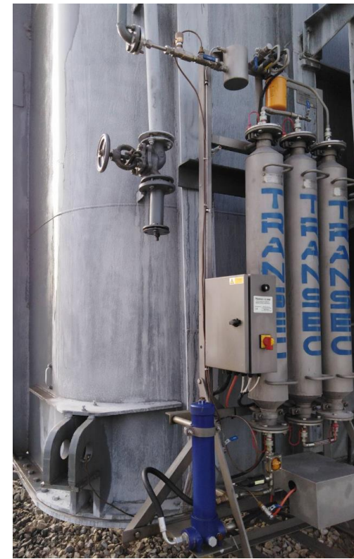
ТРДЦН- 80000/110/-75У1, 3Т, ПС-110/10/6 кВ, «Гелий-2», Южно-Уральский филиал ООО «Газпромэнерго»
