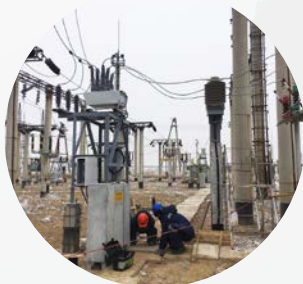
ПОДСТАНЦИОННЫЙ ВЫКЛЮЧАТЕЛЬ
